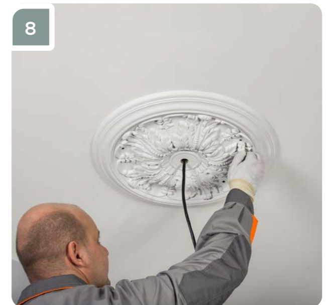
8 Финишной шпаклевкой для внутренних работ зашпаклевать места заглубления саморезов.
