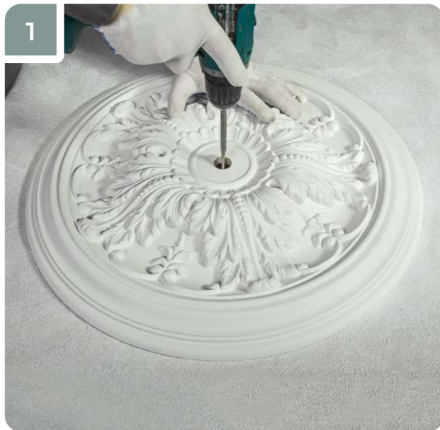
1 Просверлить в изделии отверстие необходимого диаметра.
