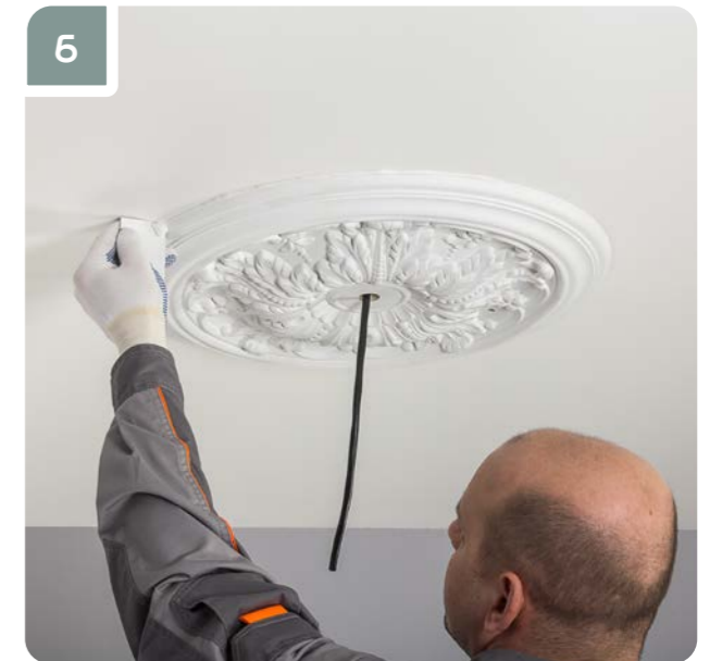
6 Сразу после приклеивания удалить выступившие излишки клея шпателем.
