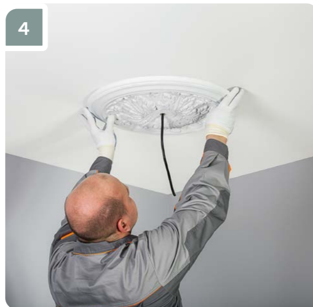
4 Приложить изделие к месту установки. Прижать изделие по всей окружности, чтобы клей выступил из-под всей плоскости примыкания
